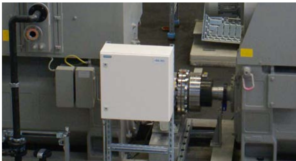
直列モーター間のシャフトにフリーシャフトエンドなし No free shaft end at connection shaft between tandem motors
